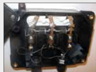
Diodos de derivación en el módulo
