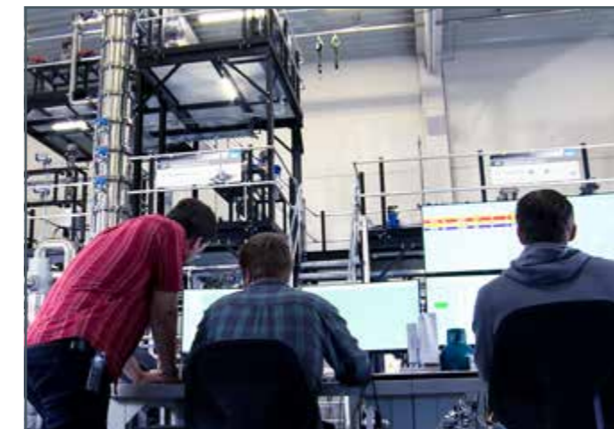
IPP durante el funcionamiento de prueba antes de la entrega de la planta
