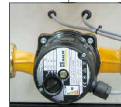
Bomba de circulación no regulada con números de revoluciones seleccionable (clase de eficiencia C)
