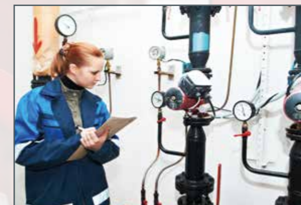
Control de los componentes de la instalación
