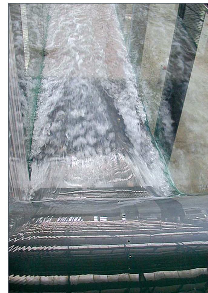
Vista en planta en la descarga sobre la presa-vertedero de perfil Ogee HM 161.34
