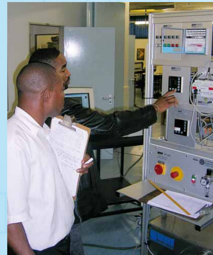
Trabajos de ajuste en un regulador digital
