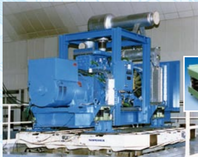
Aislamiento antivibraciones con resortes helicoidales Fuente: www.gerb.com
