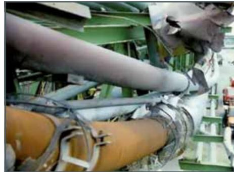
Tubería y soportes de tubo destruidos como consecuencia de un golpe de ariete
