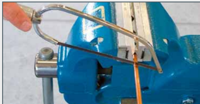
Determinación de la longitud de la sección de la tubería. Para ello, han de tenerse en cuenta los añadidos para curvaturas y rebordes. Serrado de la tubería.
