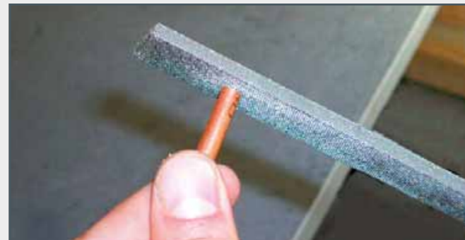
Limado de la sección cortada. La superficie de corte tiene que estar colocada perpendicularmente respecto al eje de la tubería.
